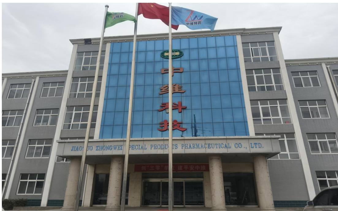
图 1 焦作中维特品药业股份有限公司厂区
